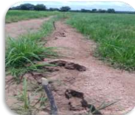
Rodage de la diguette de ceinture
