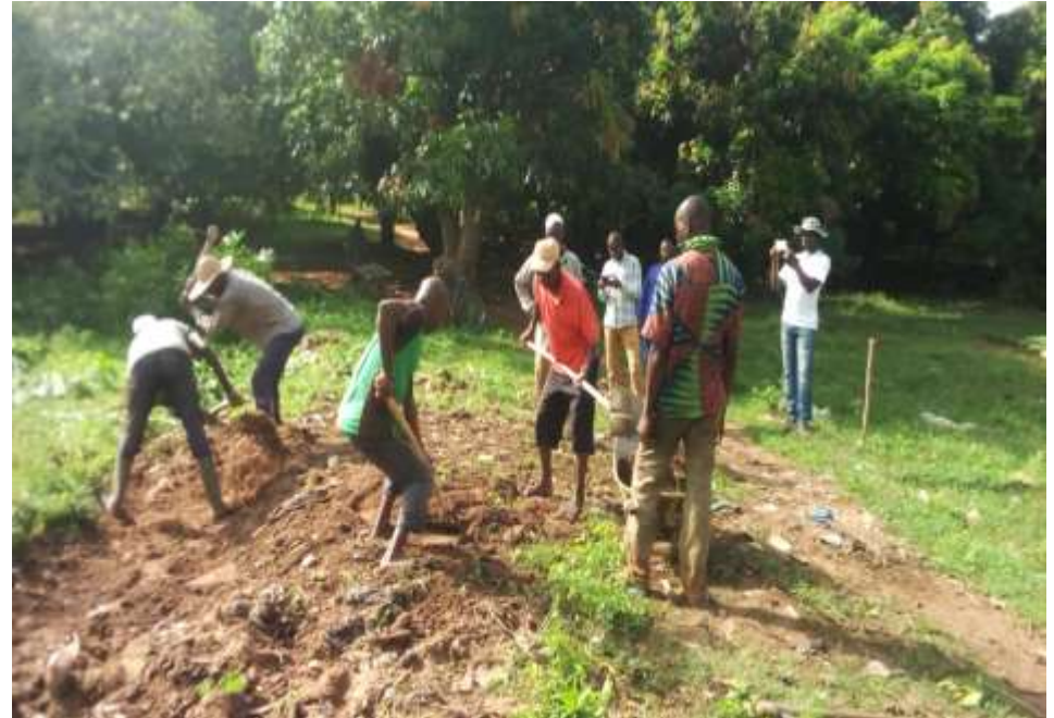
Etape 6: construction des diguettes
